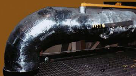
Pipe & Duct Lagging
